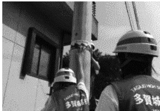
図4 波高標識設置
